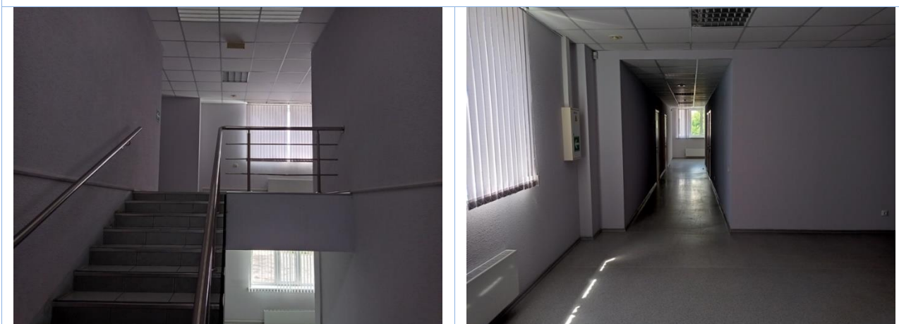
Внутренний вид административного здания, 2 этаж
